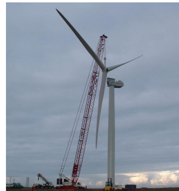
Montage du rotor
